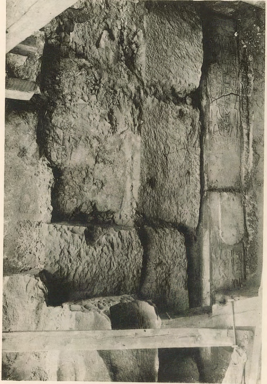
Les piliers P 4 et P 16 en place au fond du pylône. (Karnak III e pylône, aile Sud).
